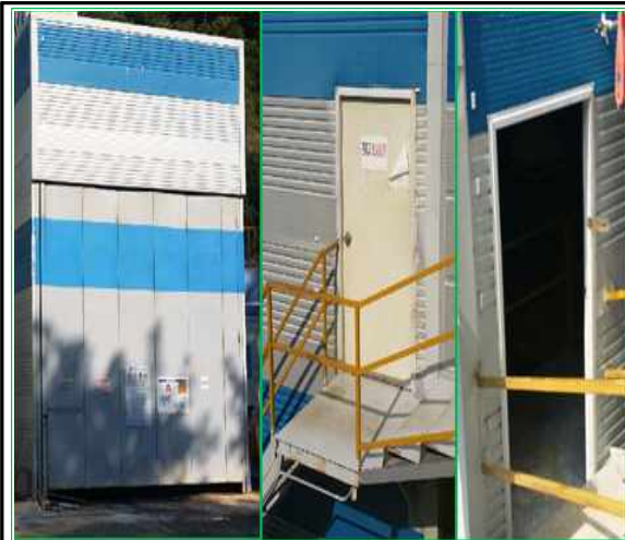
개선 전 하역장 출입문
