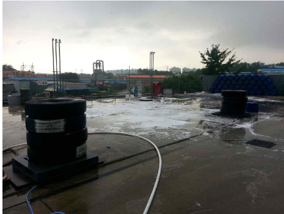
사고 현장과 사고 탱크
