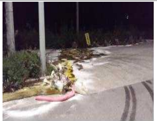
유출 방지둑 설치
